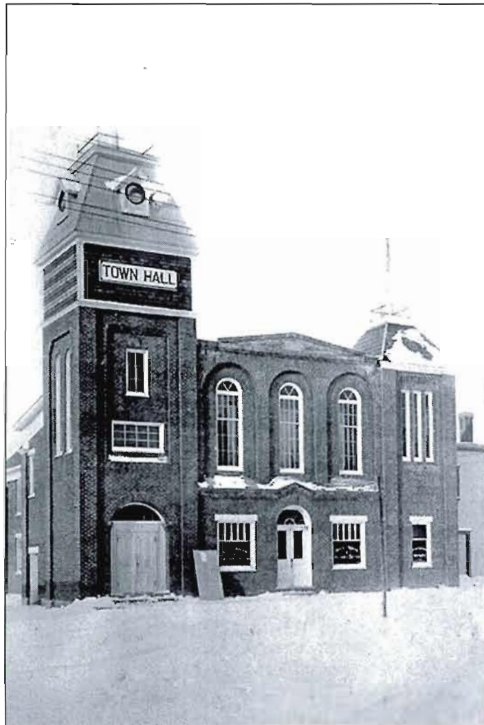
Fig. E.13.2. L'hôtel de ville de Sutton à la suite des rénovations réalisées en 1912, date indéterminée. Source : Bibliothèque et Archives nationales du Québec, Collection numérique, n° c02327.
