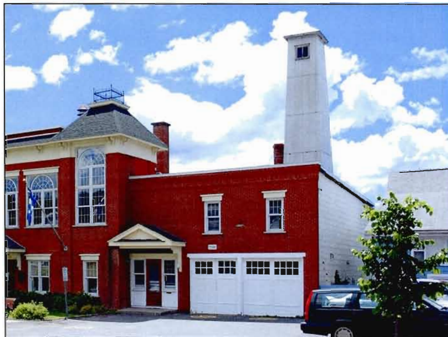
Fig. F.4.1. Façades avant et latérale droite de la caserne d'incendie de Sutton. Photo : C. Lefebvre, 2009.
