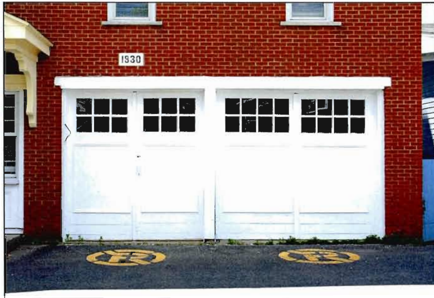
Fig. F.4.5. Détail de la façade principale. Photo : C. Lefebvre, 2009.
