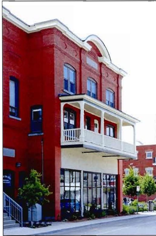
Fig. E.14.7. Caserne d'incendie et poste de police de Famham, convertis en bibliothèque municipale. Photo : C. Lefebvre 2009.
