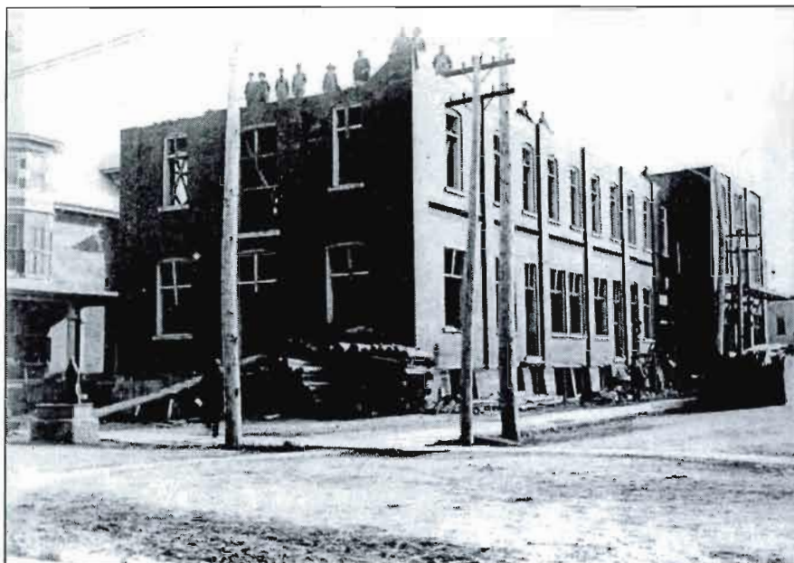
Fig. E.14.2. Deuxième hôtel de ville de Farnham au moment de sa construction, en 1912-1913. Photo : Coll. Alban Berthiaume.
