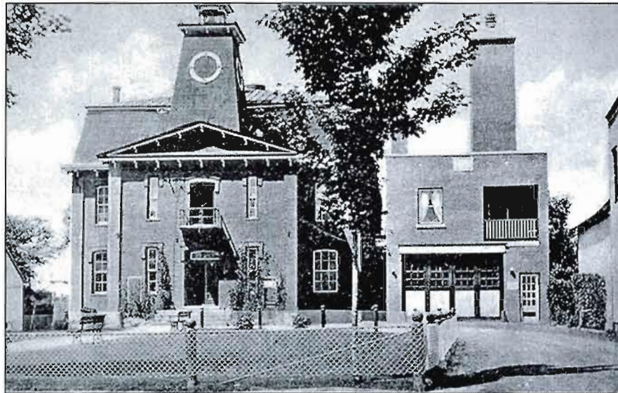
Fig. F.2.1. Hôtel de ville (gauche) et caserne d'incendie (droite) de Cowansville, carte postale, date indéterminée. Source : Bibliothèque et Archives nationales du Québec, Collection numérique, n° c00441.
