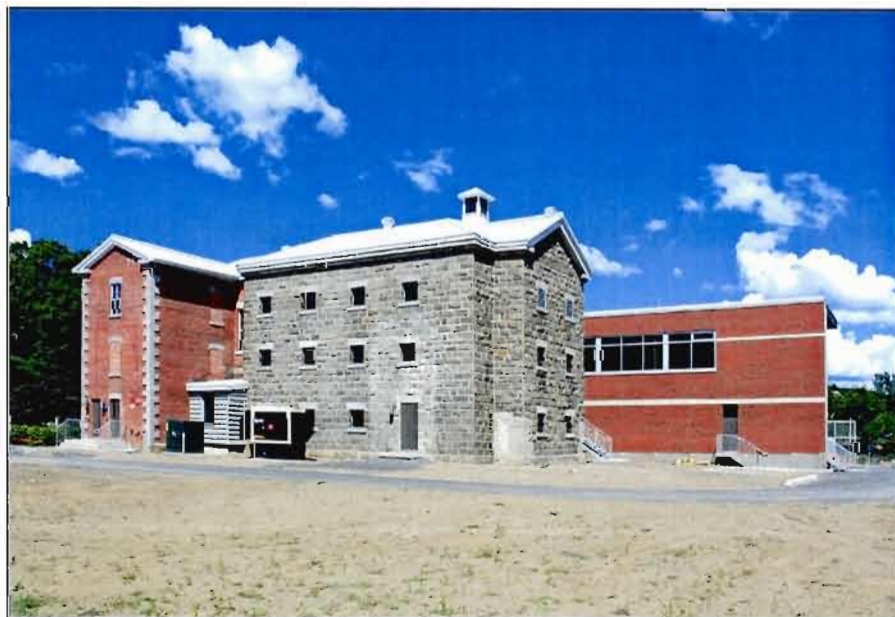
Fig. B.1.4. Façades latérale droite et arrière du palais de justice du district judiciaire de Bedford, Cowansville. Photo : C. Lefebvre, 2009.
