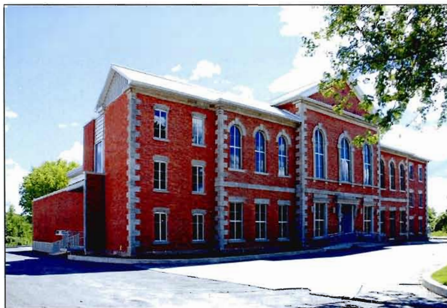
Fig. B.1.1. Façades avant et latérale gauche du palais de justice du district judiciaire de Bedford, Cowansville. Photo : C. Lefebvre, 2009.
