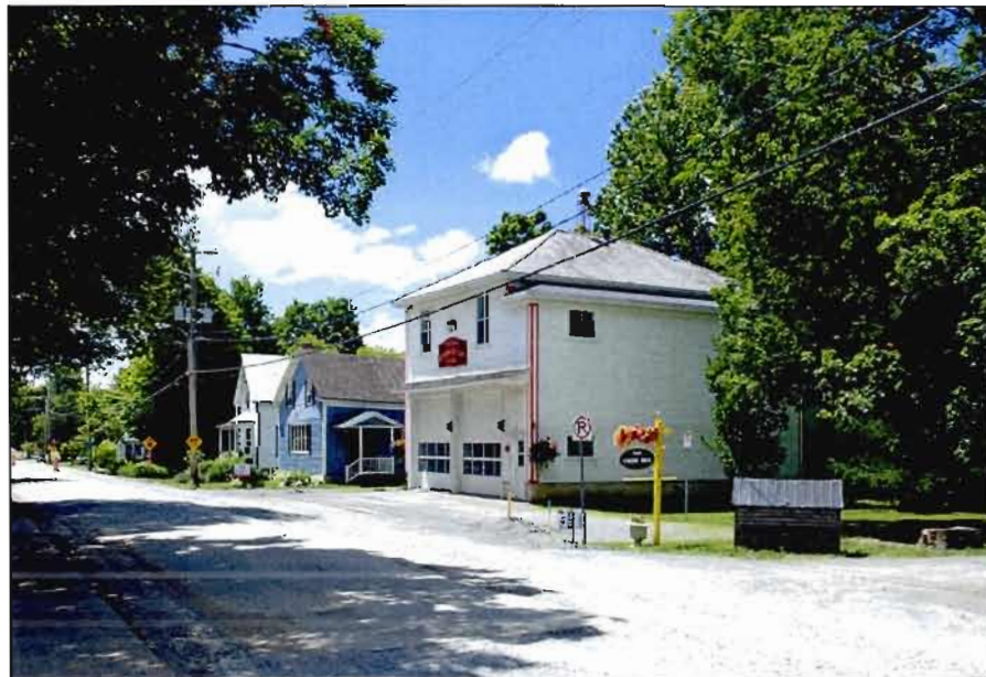
Fig. E.12.5. Vue d'ensemble à l'approche du site (direction opposée). Photo : C. Lefebvre 2009.
