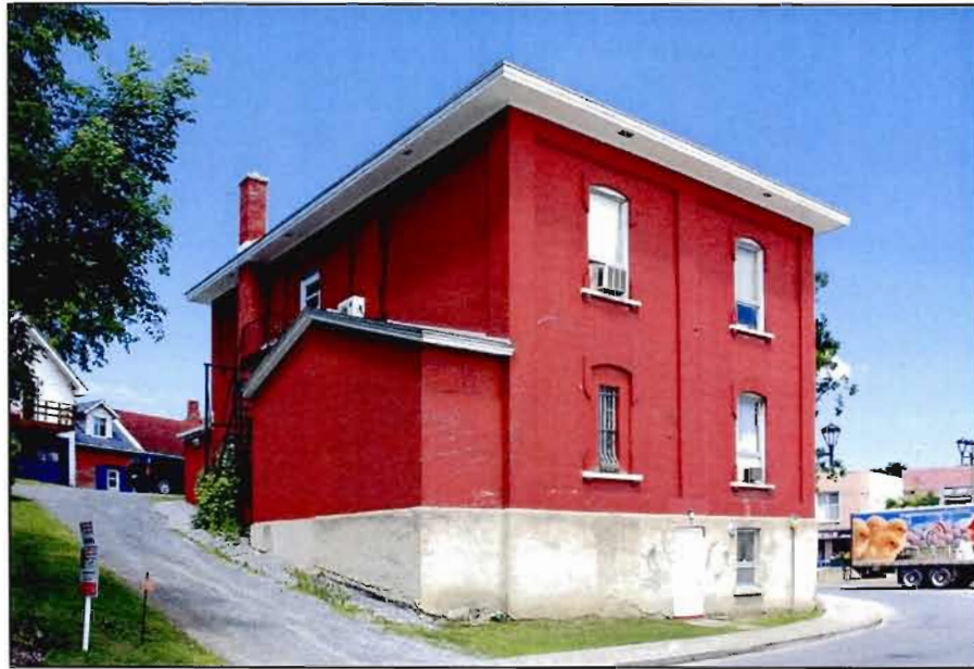
Fig. D.4.8. Façades latérale gauche et arrière du palais de justice du comté de Missisquoi, Bedford. Photo : C. Lefebvre, 2009.
