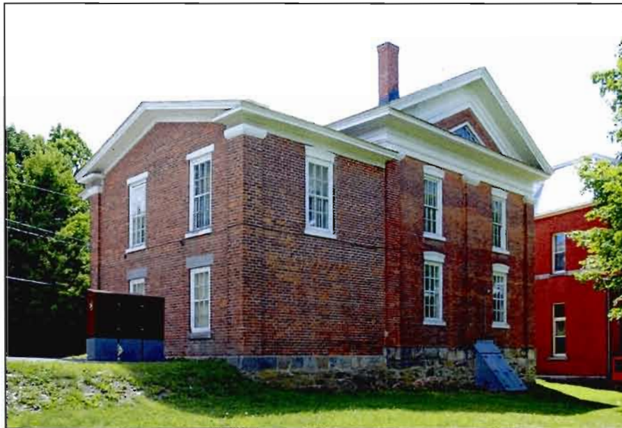
Fig. D.2.8. Façades latérale droite et arrière du palais de justice du comté de Brome, Lac Brome (Knowlton). Photo : C. Lefebvre, 2009.
