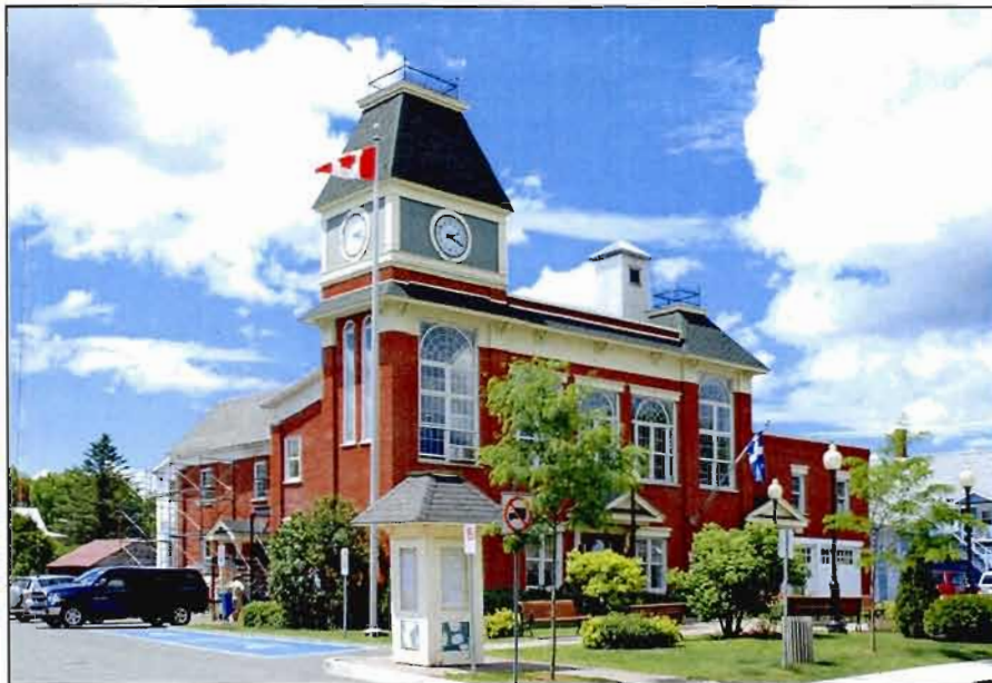
Fig. E.13.1. Façades avant et latérale gauche de l'hôtel de ville de Sutton. Photo : C. Lefebvre, 2009.
