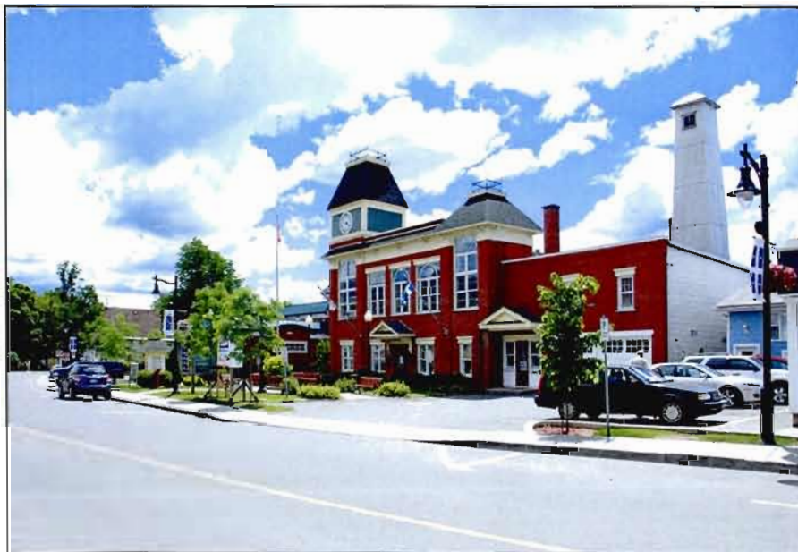
Fig. F.4.6. Vue d'ensemble à l'approche du site. Photo : C. Lefebvre, 2009.
