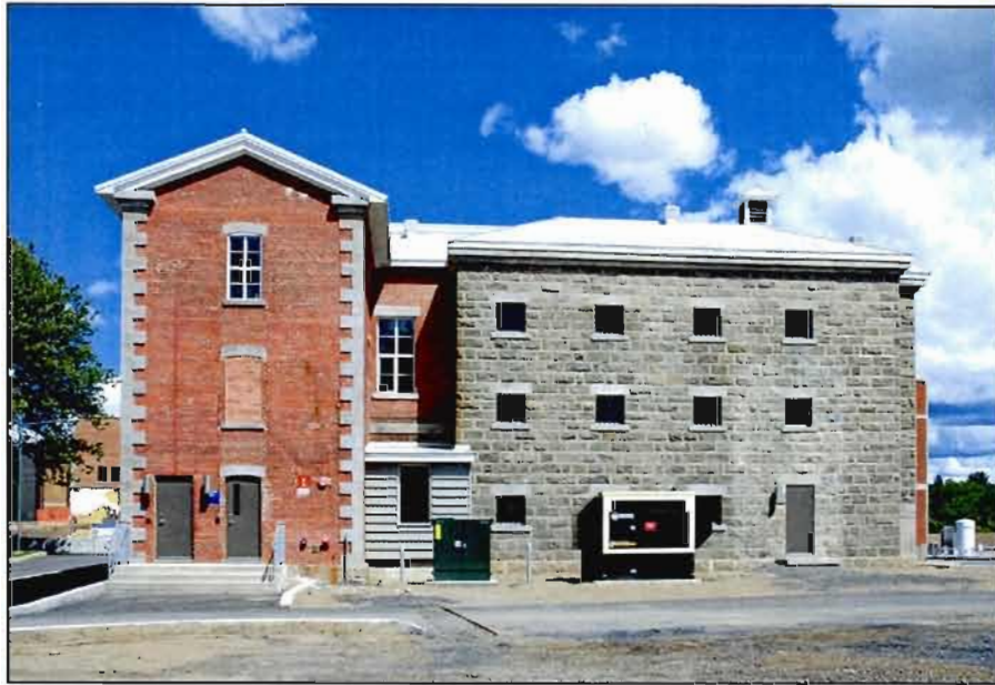
Fig. B.1.5. Façades latérale droite et arrière du palais de justice du district judiciaire de Bedford, Cowansville. Photo : C. Lefebvre, 2009.
