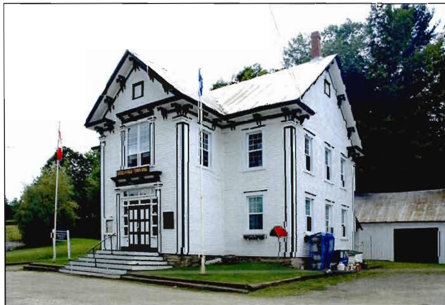
Fig. E.4.5. Façades avant et latérale droite de l'hôtel de ville de Bolton-Est. Photo : C. Lefebvre, 2007.
