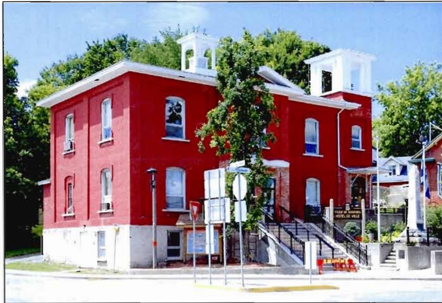
Fig. D.4.1. Façades avant et latérale gauche du palais de justice du comté de Missisquoi, Bedford. Photo : C. Lefebvre, 2009.
