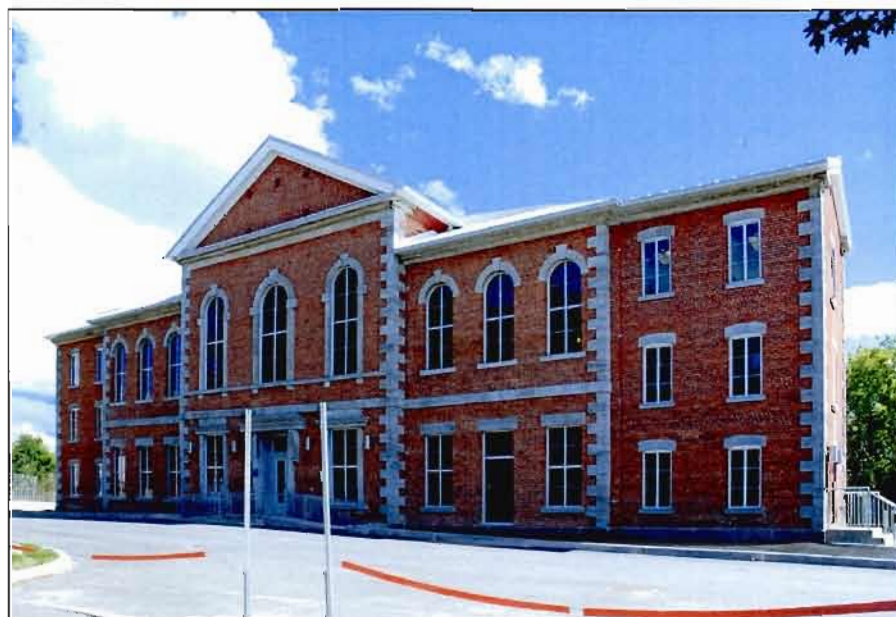
Fig. B.1.6. Façades latérale droite et arrière du palais de justice du district judiciaire de Bedford, Cowansville. Photo : C. Lefebvre, 2009.
