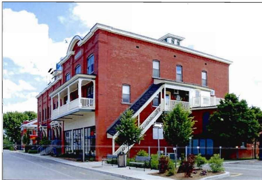
Fig. E.14.6. Façades latérale droite et arrière du deuxième hôtel de ville, caserne d'incendie et poste de police de Farnham. Photo : C. Lefebvre 2009.
